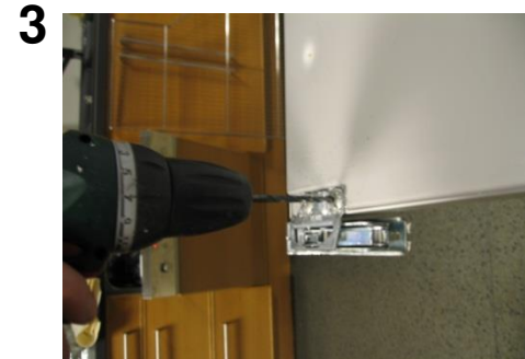
3. Bor ut de gamle hengslene med et 5 mm bor.
